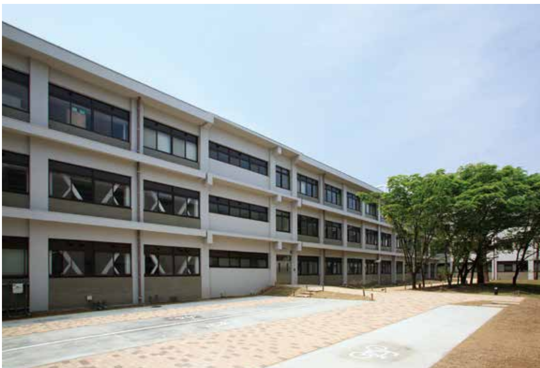
総合科学部1号館の耐震改修の例（室内に耐震プレスを設置している）
