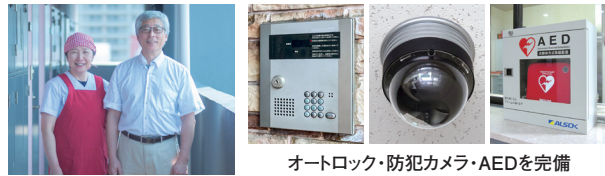
オートロック・防犯カメラ・AEDを完備
