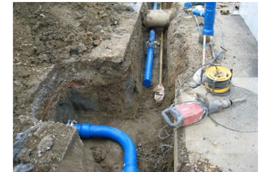
耐震性のあるポリエチレン管に更新
