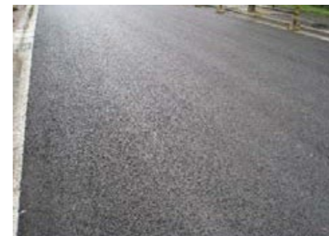
透水性アスファルト舗装
