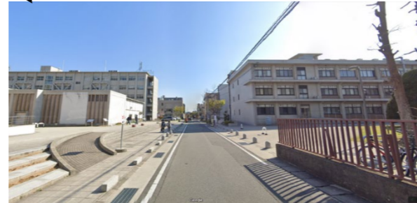
将来的に整備を行いたい市道
