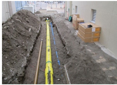
耐震性のあるポリエチレン管に更新
