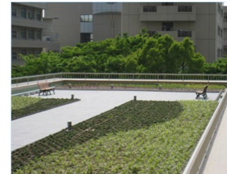
保健学C棟屋上
