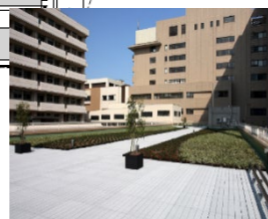
屋上緑化 (保健学C棟)
