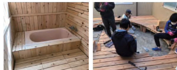
ひのき風呂への改修
