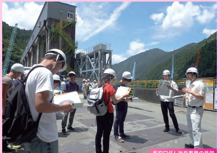
長安ダム改良事業の見学
