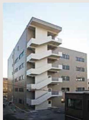
(南常三島) フロ ンティア研究セン ター新営 (平成 26年12月完成)
