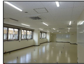
照明設備更新(LED化)
