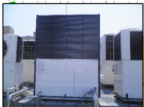
高効率空調設備更新
