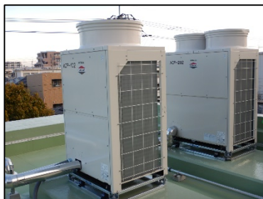
高効率空調設備更新
