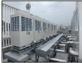
高効率空調設備更新
