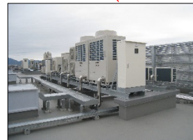
高効率空調設備更新
