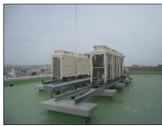
高効率空調機への更新
