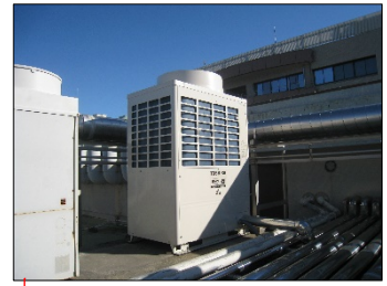
高効率空調機への更新
