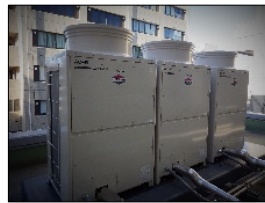
高効率空調設備更新
