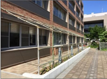
・花壇に沿って幅14m 高さ3mの範囲に、竹を利用して花壇と庁舎の間の歩道を囲うように支柱を設置しました。
