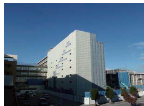
【防音パネルの設置】
