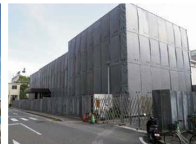
【防音シートの設置】
