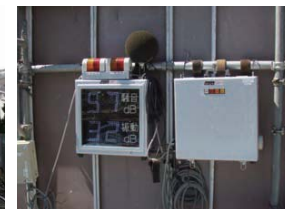
【騒音振動計の設置】
