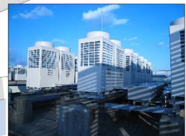
高効率空調機への更新
