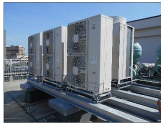
高効率空調機への更新
