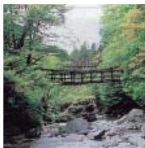
『祖谷溪・祖谷のかずら橋』 平家の落人が考案したと言 われてるシラクカズラのつ るを使って作る。 橋の下は深い溪谷で、歩く たびに揺れてスリル満点。
