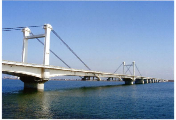
平成24年4月に開通した阿波しらさぎ大橋
