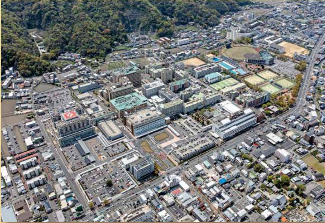
徳島大学蔵本キャンパスの航空写真。2つの矢印が画像上で交差するところの建物が保健学科棟です。
