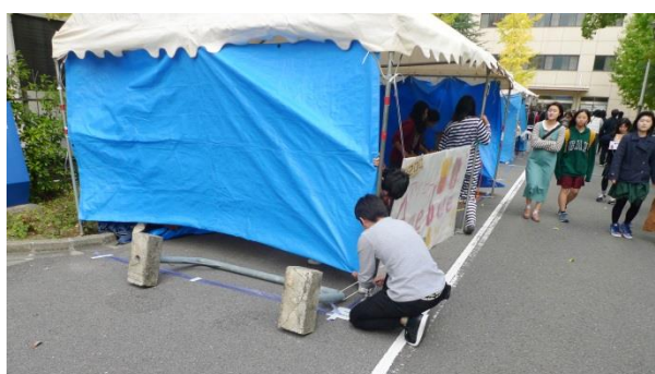
図4 緊急風対策の様子1
