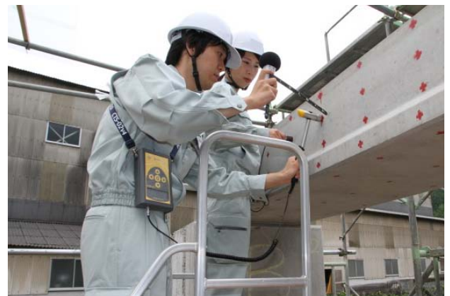
図5 非破壊試験の様子
