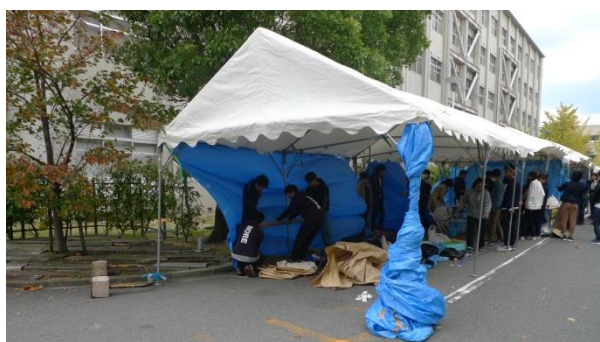
図5 緊急風対策の様子2
