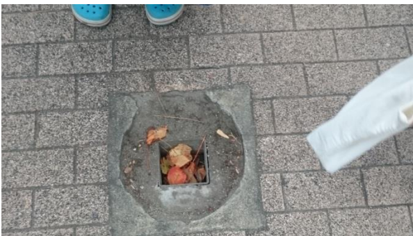
図10 車止めを撤去した後の穴
