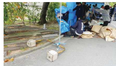
図3 緊急風対策の様子
