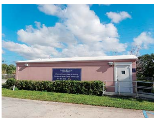
写真1 センターの外観
