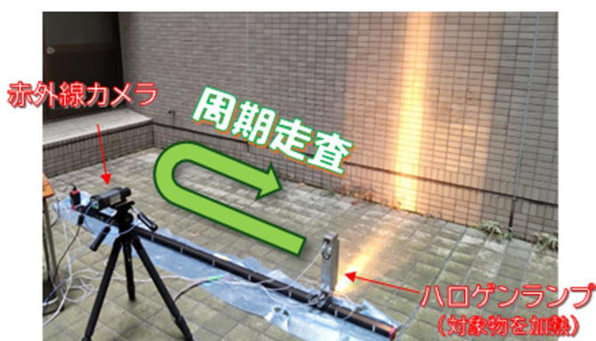
図1. 建物外壁(タイル壁面)への周期走査加熱を利用したアクティブサーモグラフィ検査の様子
