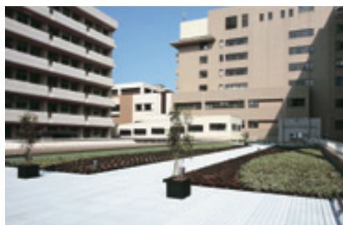
保健学C棟屋上庭園
