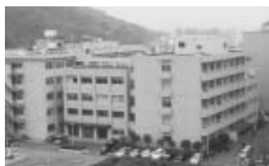
写真2 医療技術短期大学部校舎 鉄筋5階建てを南、北、西側に増設 建築年昭和63年
