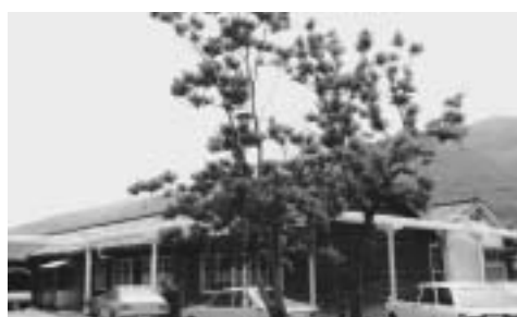
写真1:旧看護学校、診療エックス線技師学校、衛生検査技師学校の木造2階建(旧幹部兵舎) 建築年1906年
