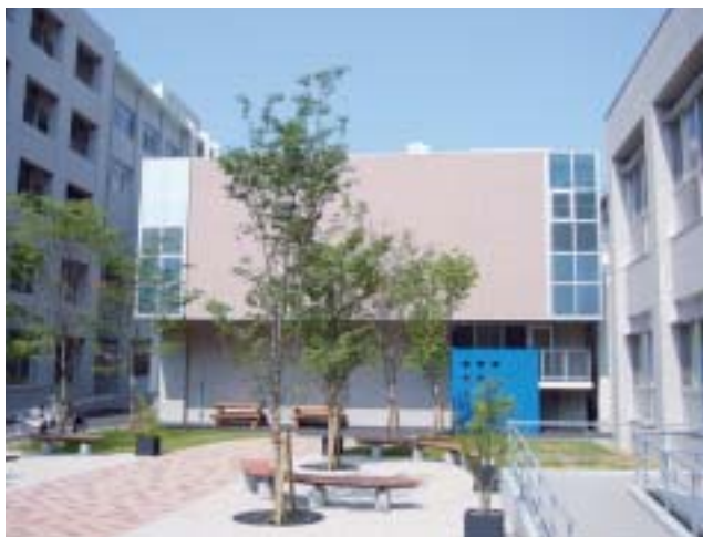
▲ 写真1：基礎B棟，基礎医学講義棟
