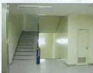
総合実習室による改修後の階段付近
